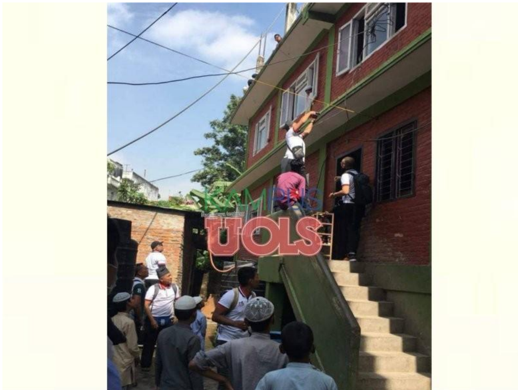
CSR pemasangan lampu solar di salah sebuah bangunan di Kathmandu, Nepal.
