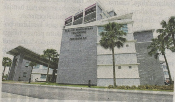
Kemudahan bangunan untuk penuntut program Sarjana Muda Pengurusan Teknologi (Pembinaan), UTHM.
