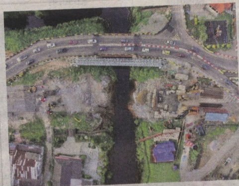
Pandangan dari udara Jambatan Parit Keliling di Jalan Peserai yang hampir siap untuk digunakan.
