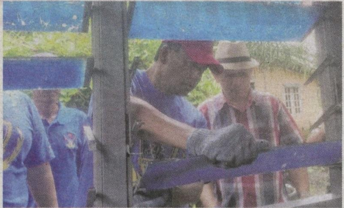
Ab Aziz memasang tingkap di sebuah rumah penerima bantuan Gotong-Royong Perdana di Kampung Tebing Tinggi.
