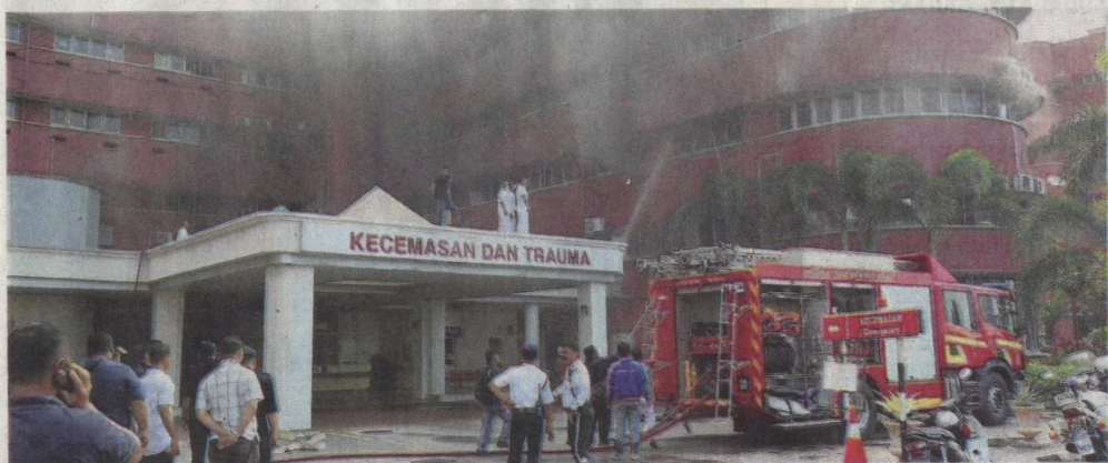
DETIK-DETIK kebakaran yang dirakam berlaku di Unit Rawatan Rapi Hospital Sultanah Aminah, Johor Bahru, pada 25 Oktober lalu. - UTUSAN/RAJA JAAFAR ALI
